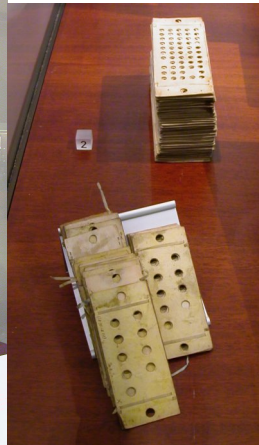
Figura: schede perforate per inserire le istruzioni alla macchina analitica.
